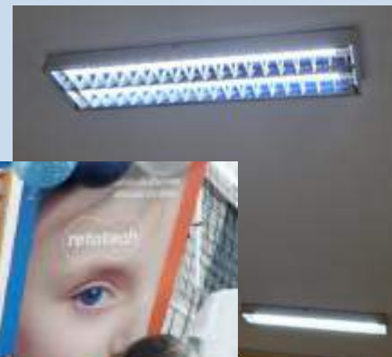
Substituição de lâmpadas.
